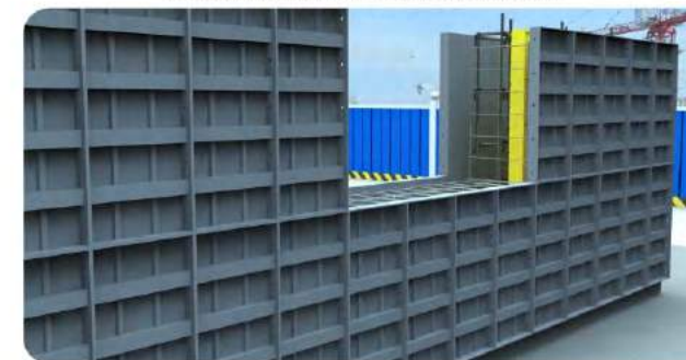
3.根据图纸安装并固定铝模板组件
