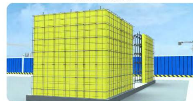
2.根据图纸安装并绑扎NBW组件
